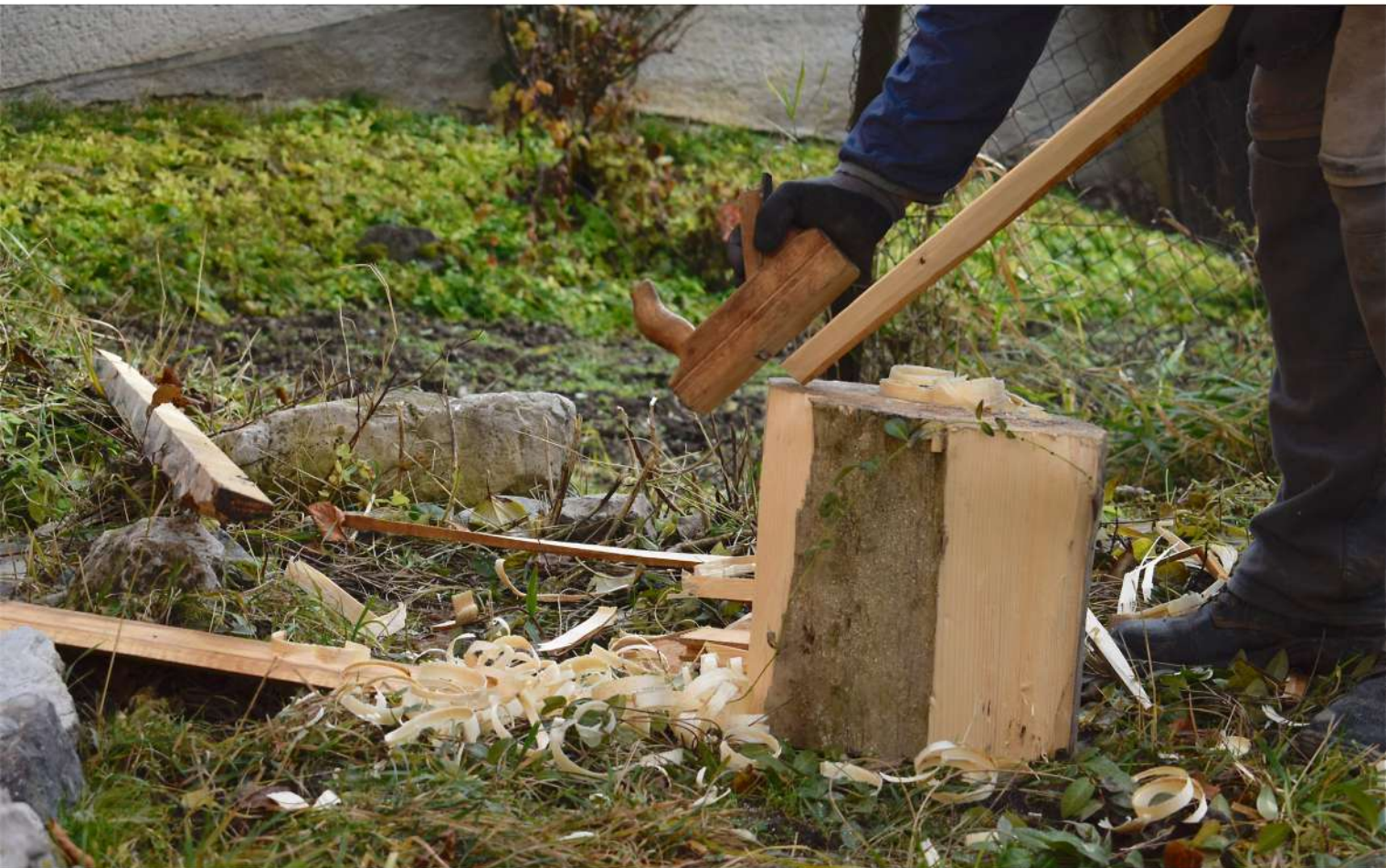
Prispôsobenie šindľa na potrebnú šírku
