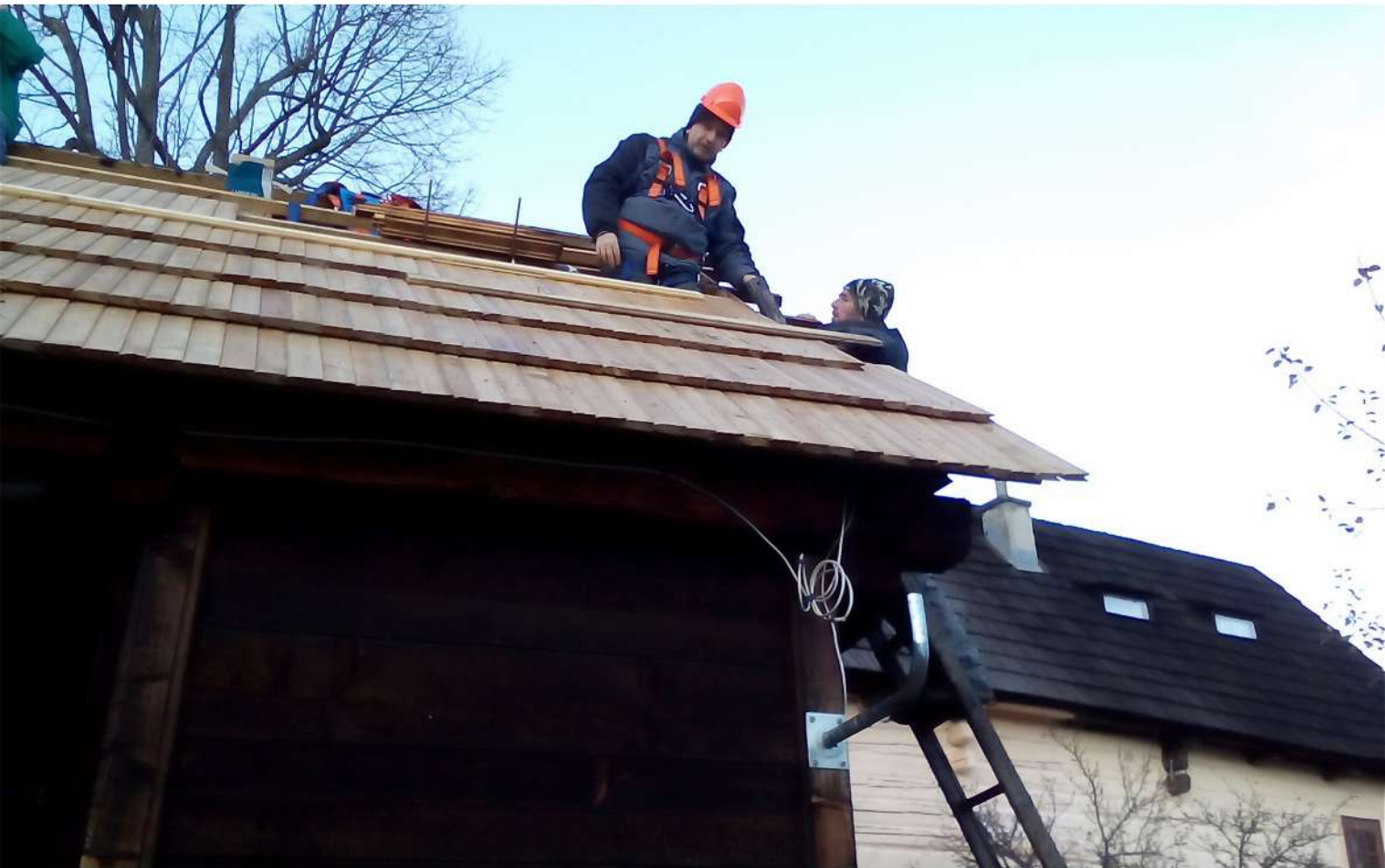
Šindľovanie hospodárskej stavby
