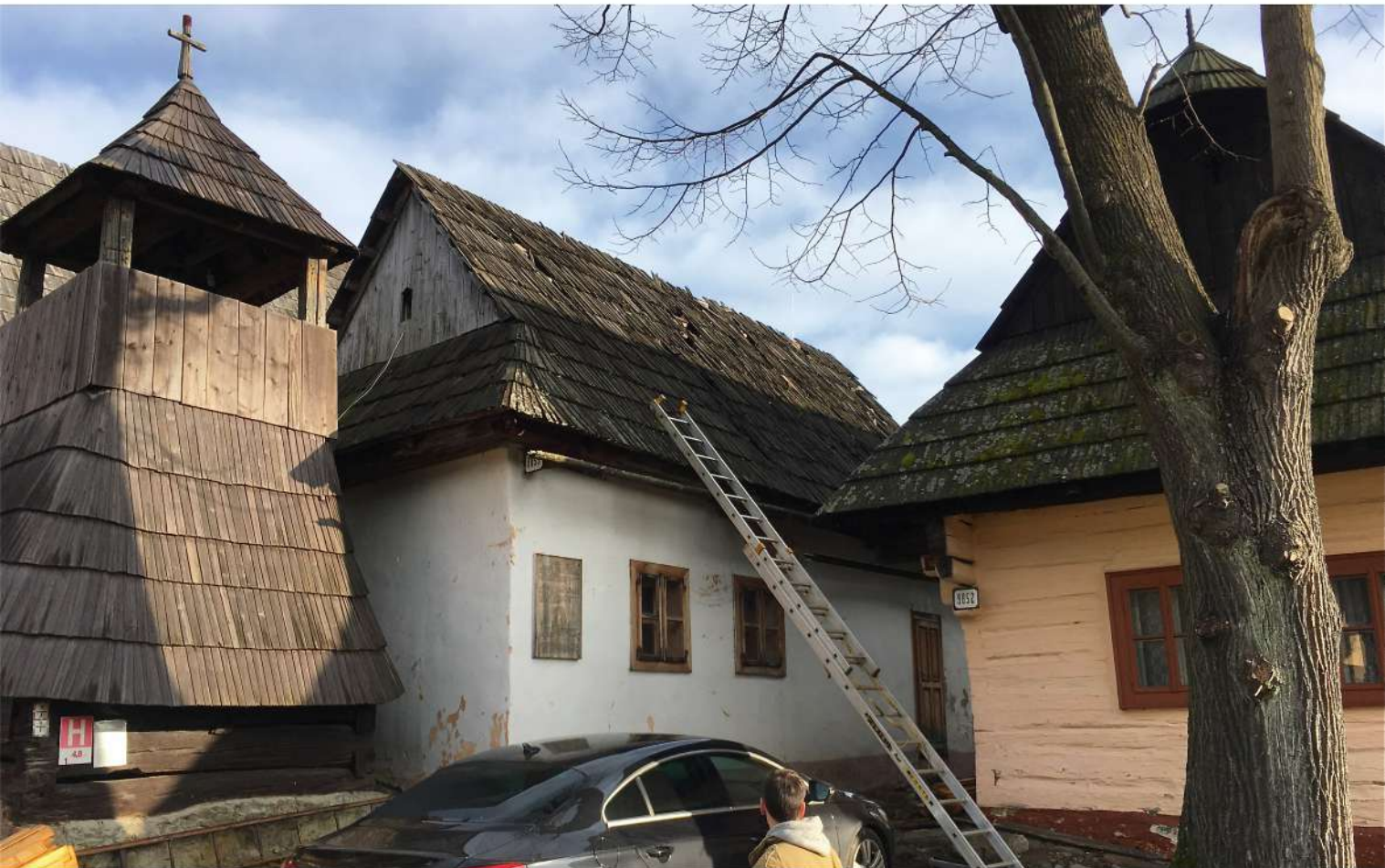
Oprava zanedbanej strechy murovaného objektu za zvonnicou, str. 1 až 8
