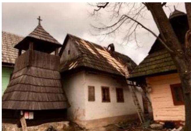
Obr. 40 Údržba strechy bývalej sýpky pri zvonici (2017) (foto: B. HOCHEL)
