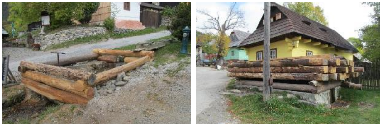
Obr. č. 5: Oprava a zvýšenie kapacity požiarnych nádrží (foto: P. Caban, jeseň 2021)
