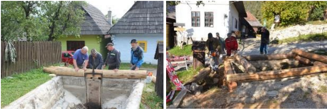
Obr. 24 a 25 Oprava výdrevy požiarnej nádrží vo Vlkolínci v roku 2020 (vľavo) a v roku 2021 (vpravo) (foto: Mesto Ružomberok).
