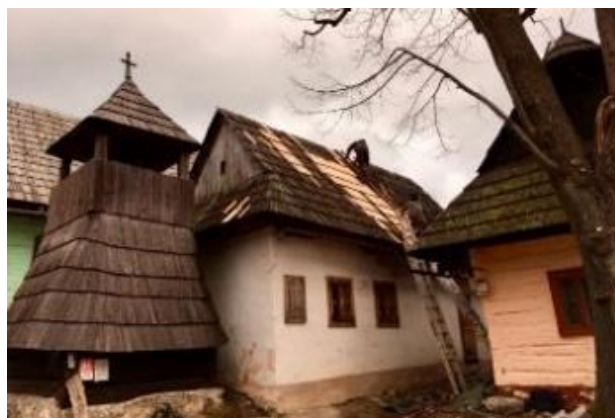
Obr. 10 Údržba strechy bývalej sýpky pri zvonici (2017) (foto: B. HOCHEL).
