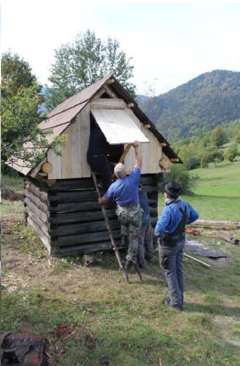
Nové odoskovanie štítov strechy vrátane osadenia typických výklopných dverí
