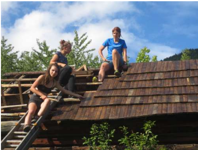
Prešindľovanie južnej strany strechy senníka
