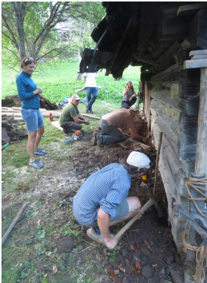
Vyberanie odhnitého trámu zrubovej časti a oprava stien prednej stĺpikovej časti
