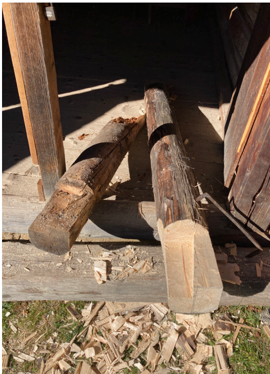
Prešindľovanie zadnej strany strechy, výroba a osádzanie nového spodného trámu.
