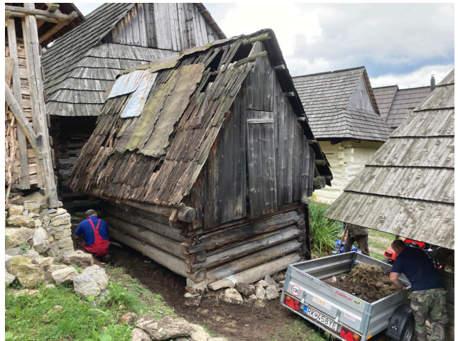
Vykopávanie maštale spod terénu a odvážanie nánosov zeminy.
