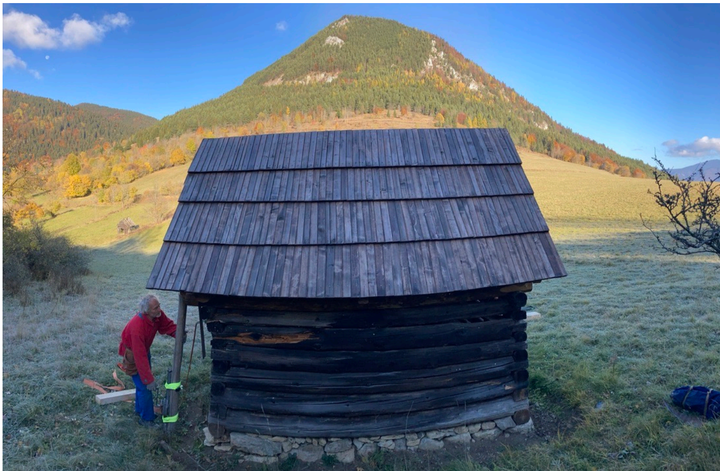
Senník „Pod Strážňou“. Príprava na výmenu dvoch trámov v hornej časti steny.
