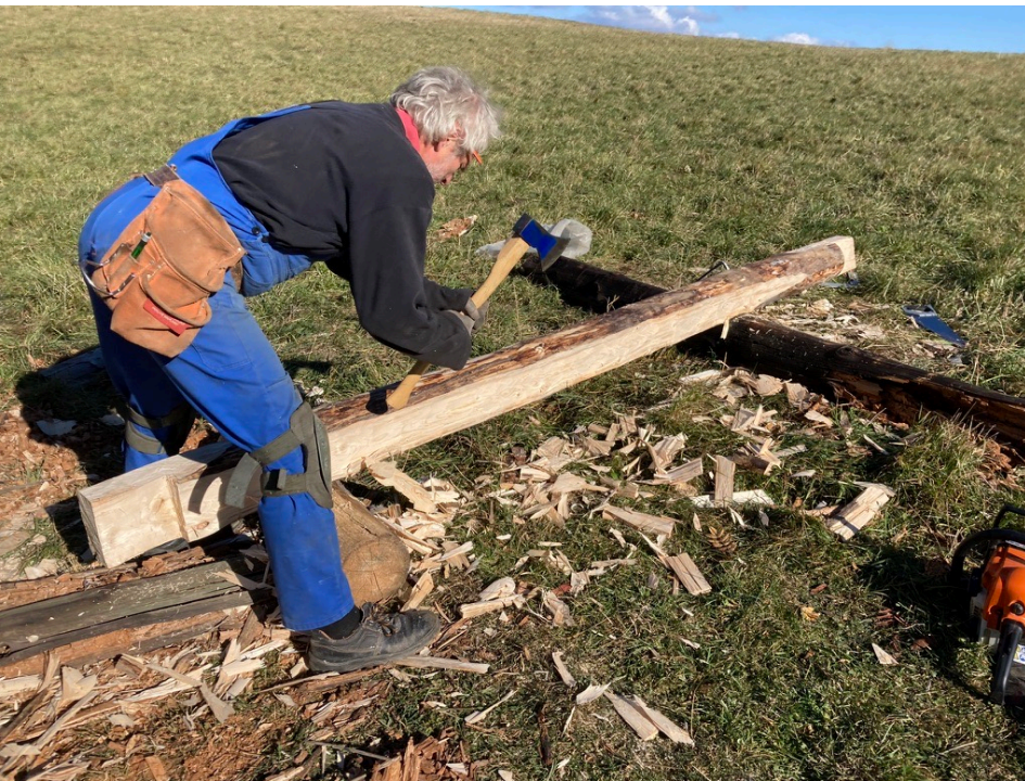
Prikresávanie druhého tramu a jeho umiestenie v stene senníka.
