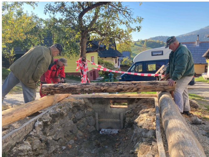
Opravovanie požiarnej nádrže umiestnenej nad potokom na hornom konci dediny.
