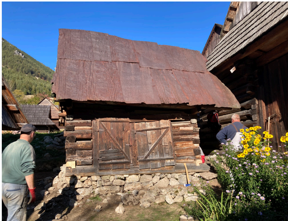
Dovoz chýbajúcich kameňov na podmurovku – kamenných základov zrubu a jej postupná renovácia.
