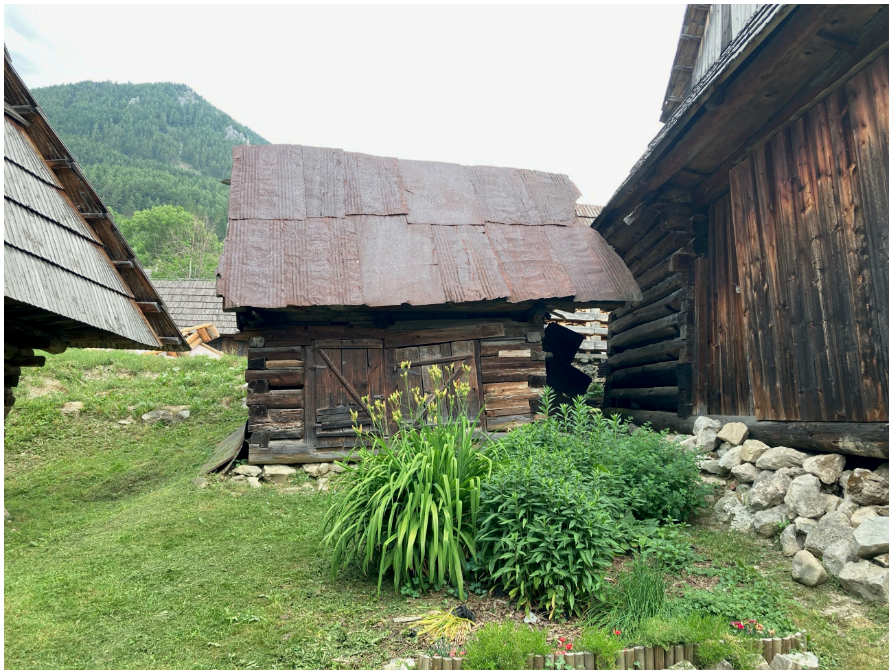
Zrubová dvojmaštal nachádzajúca sa vo dvore Liptovského múzea. Stav pred opravou v Septembri 2021
