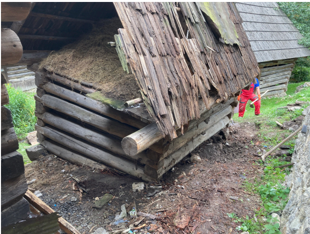
Vykopávanie maštale spod terénu a odvážanie nánosov zeminy.
