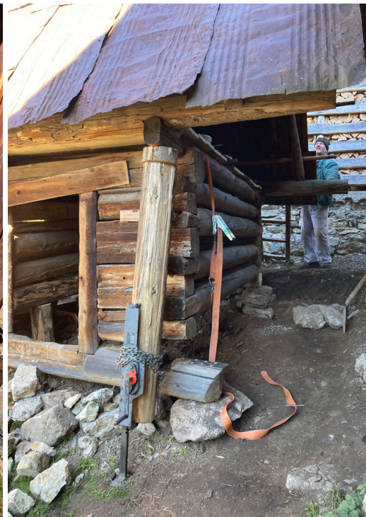
Prešindľovanie zadnej strany strechy, výroba a osádzanie nového spodného trámu.
