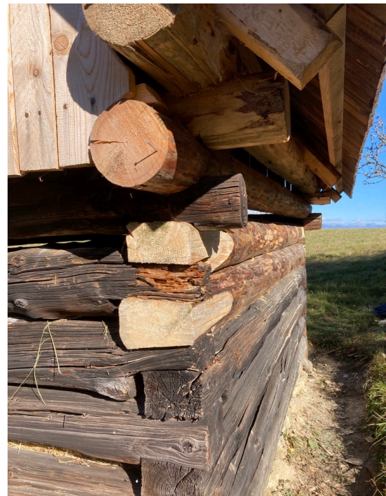
Prikresávanie druhého tramu a jeho umiestenie v stene senníka.
