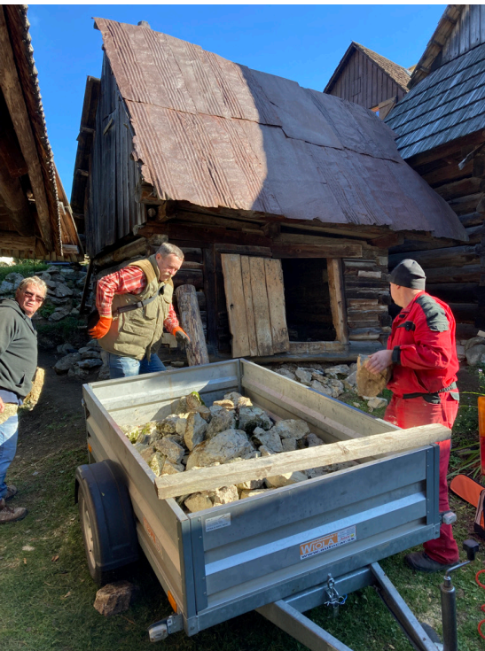
Dovoz chýbajúcich kameňov na podmurovku – kamenných základov zrubu a jej postupná renovácia.
