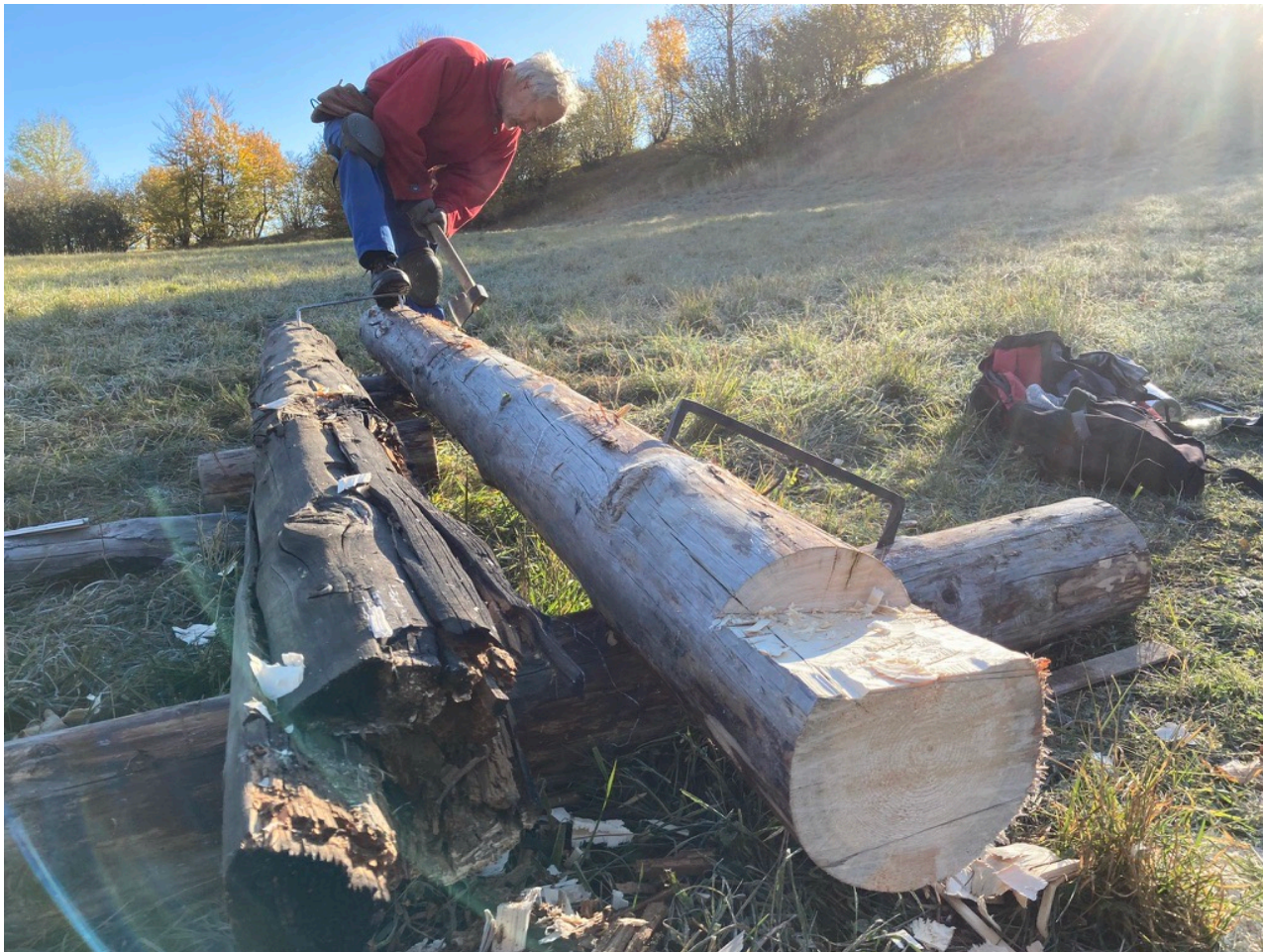
Výroba nového trámu do steny senníka podľa už málo čitateľnej predlohy.
