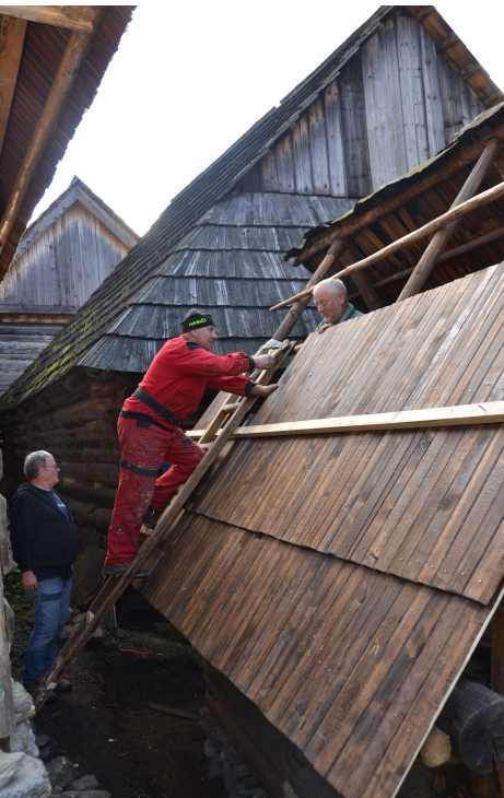
Prešindľovanie zadnej strany strechy, výroba a osádzanie nového spodného trámu.
