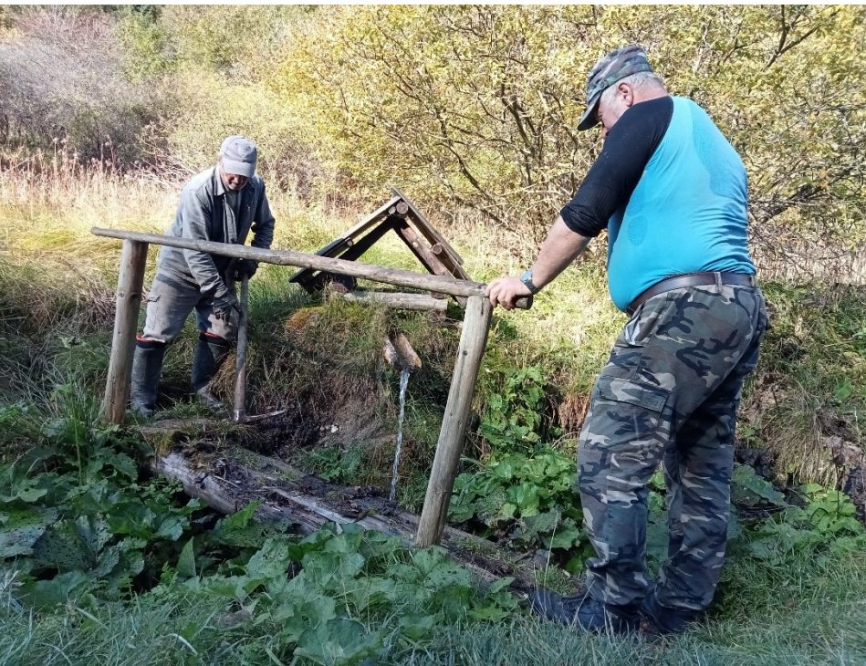
Oprava a výmena prístupu k studničkám v lokalite Vlkolínec II.
