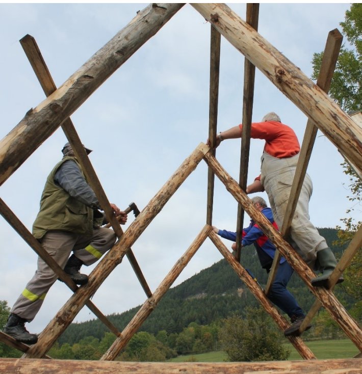
Realizácia strešnej drevenej konštrukcie – osadenie pomúrníc a krokiev.
