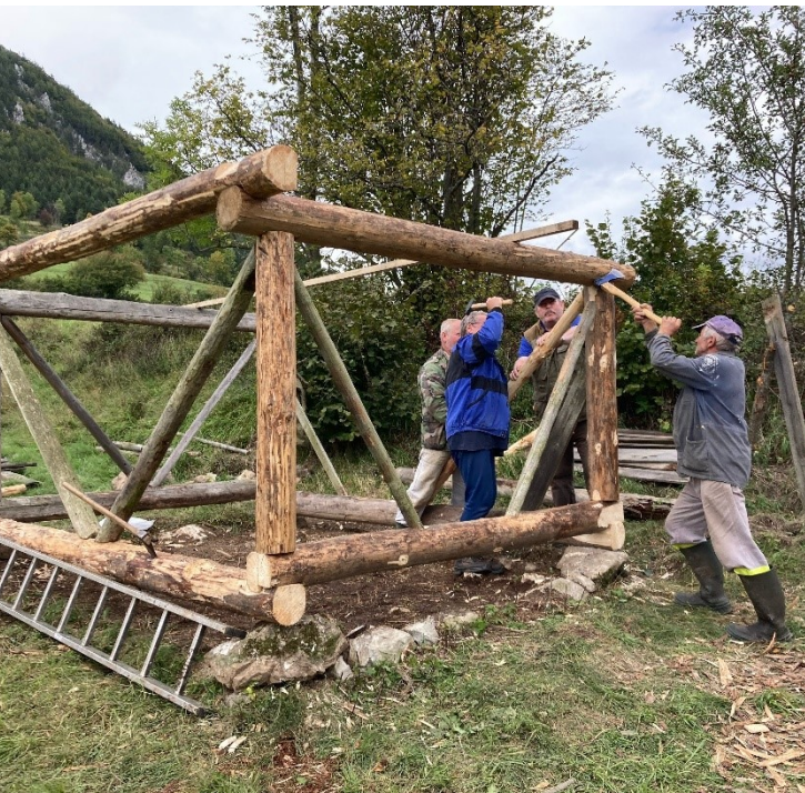
Výstavba novej nosnej konštrukcie objektu senníka II.
