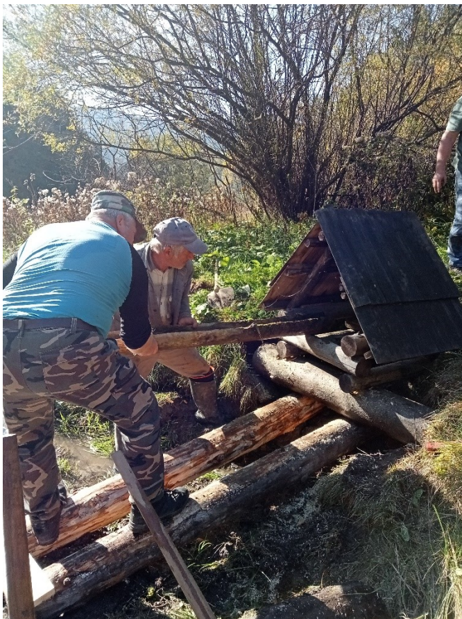
Oprava a výmena žľabov v studničkách v lokalite Vlkolíneec.
