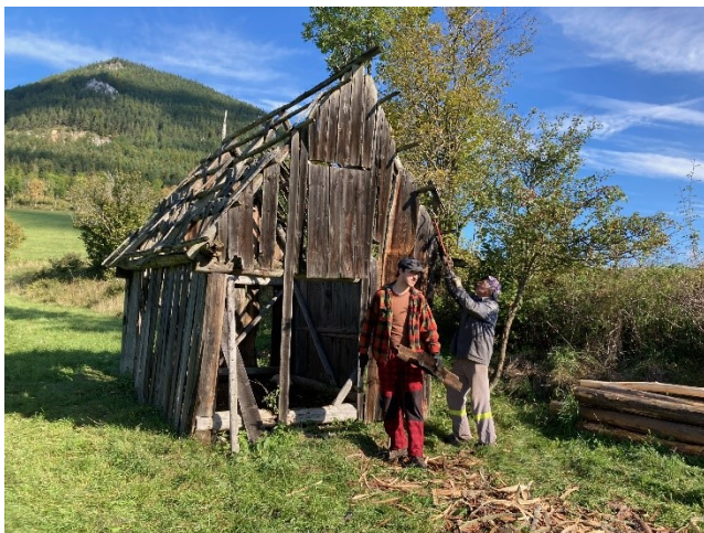
Demontáž objektu senníka, poškozených, odhnitých a zvetraných částí.
