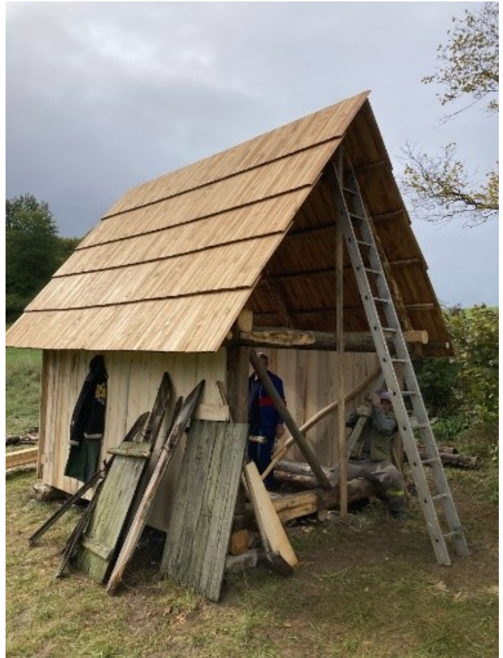
Obíjanie objektu senníka drevenými hnanými nehobl'ovanými doskami.
