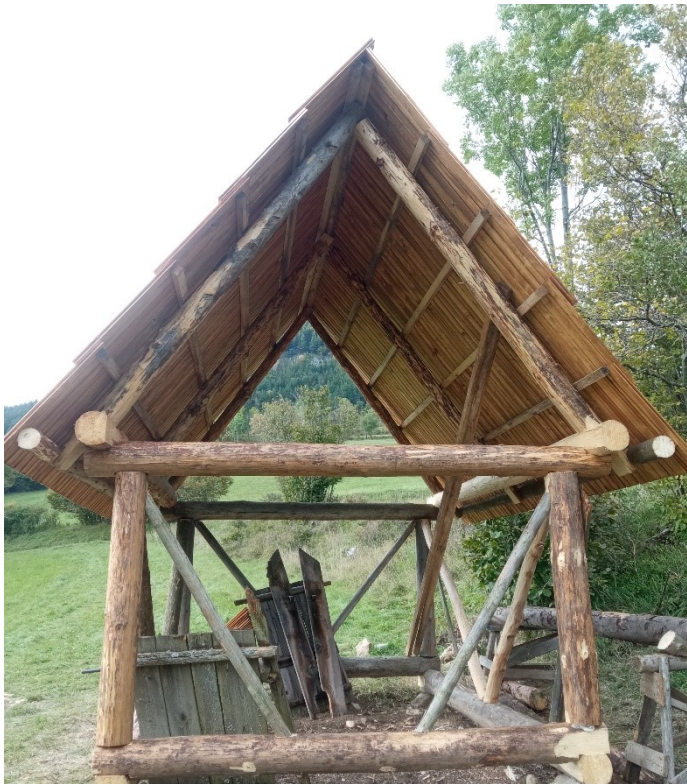
Kladenie šindľovej drevenej strešnej krytiny.
