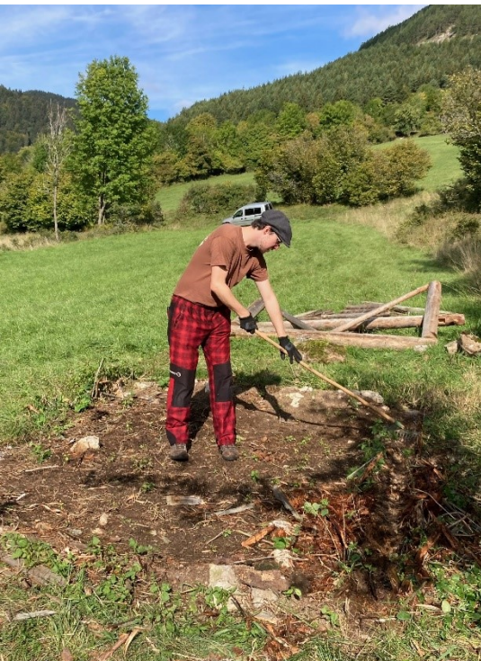
Úprava terénu pod nový objekt senníka, realizácia kamenného vyvýšeného podkladu.
