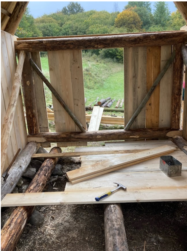
Realizácia drevenej podlahy z hranených nehobľovaných dosiek.
