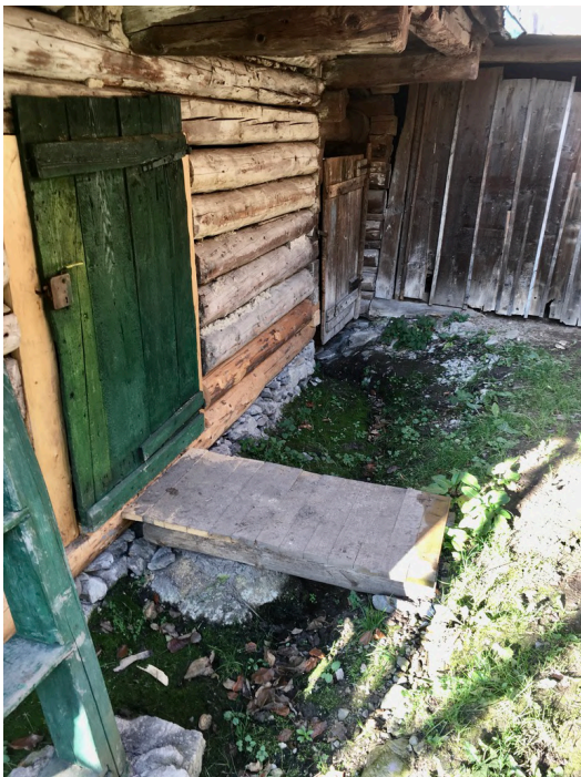
Pokračovanie prác z predošlého roka – kamenná podmurovka a odvodňovací žľab na zrubovej stavbe bývalej maštale
