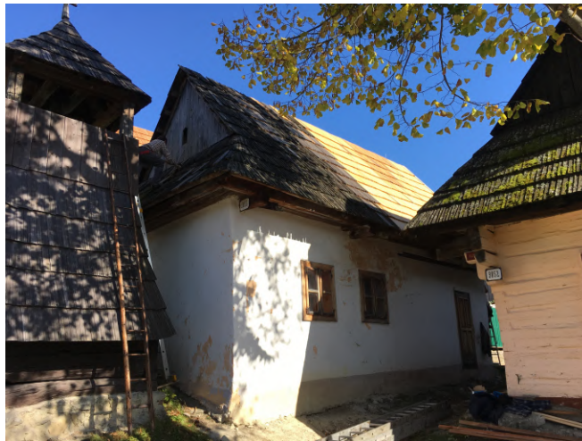
Najviac poškodená časť strechy bola nahradená novými šindľami
