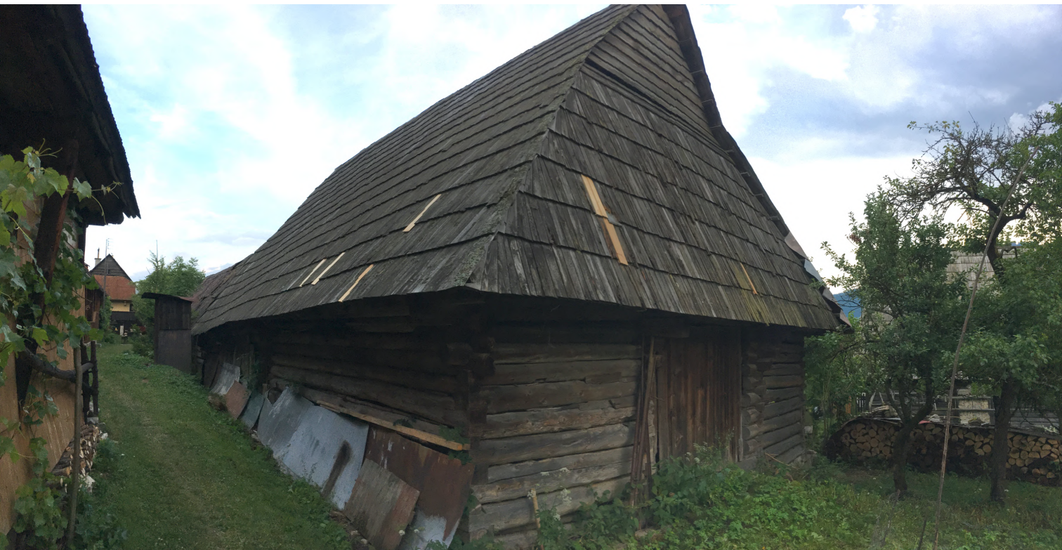
Údržba šindľovej strechy najväčšej sýpky vo Vlkolínci
