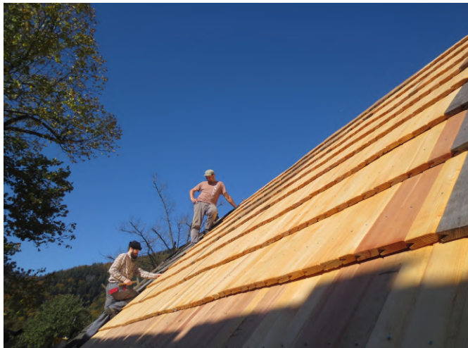
Najviac poškodená časť strechy bola nahradená novými šindľami
