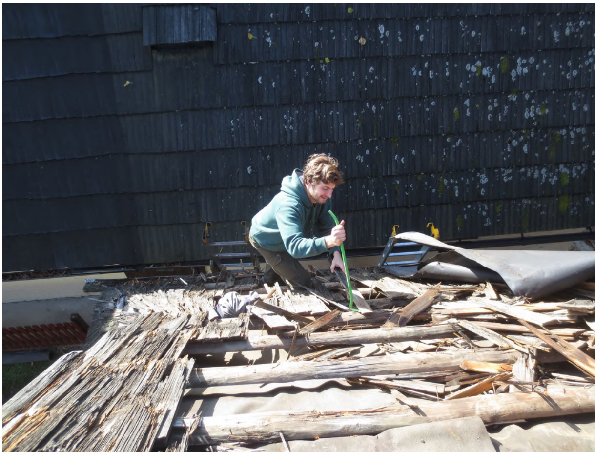
Prípravné práce na streche sýpky pri zvonici – rozoberanie zvyškov šindľov
