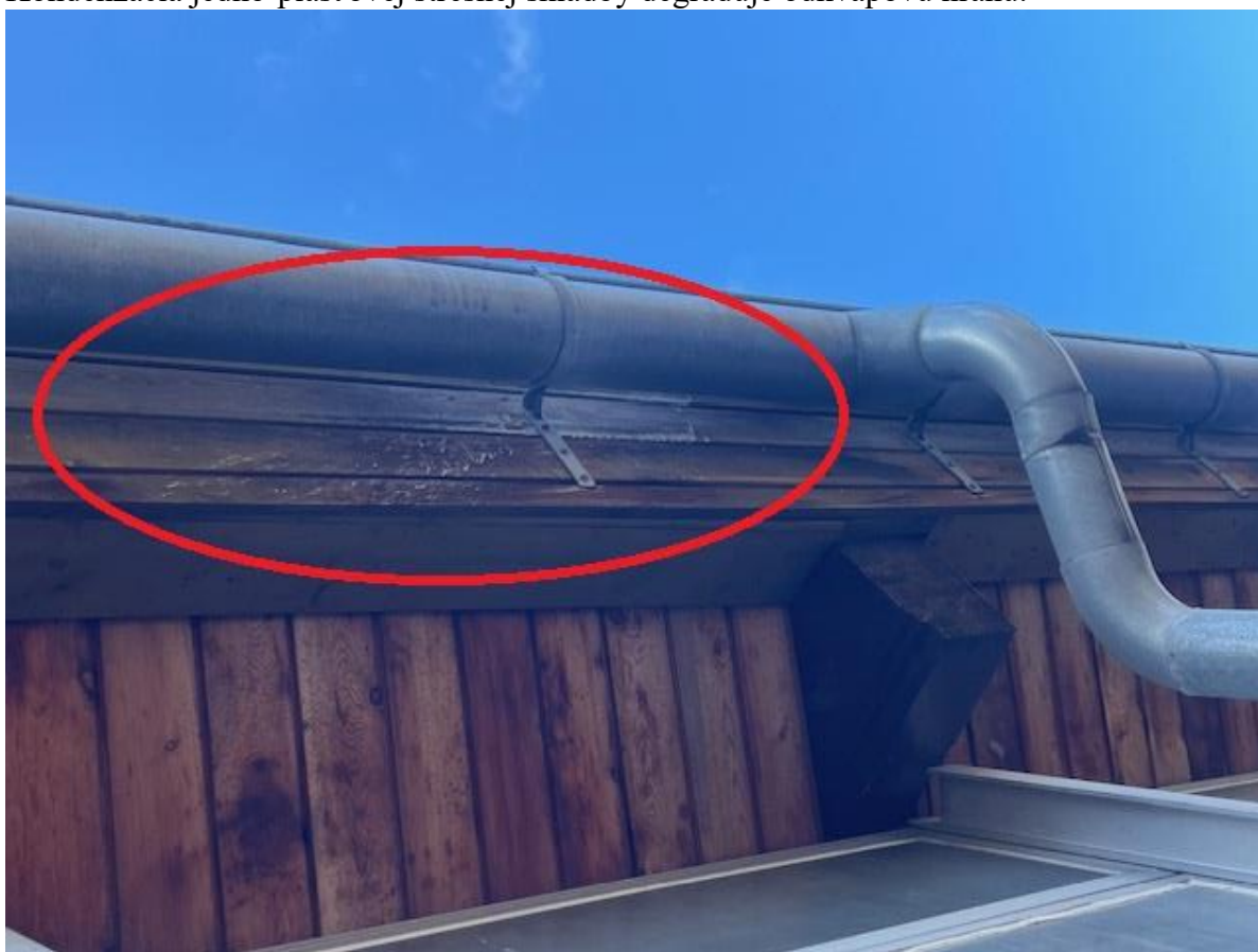
Kondenzácia jedno-plášťovej strešnej skladby degraduje odkvapovú hranu.
