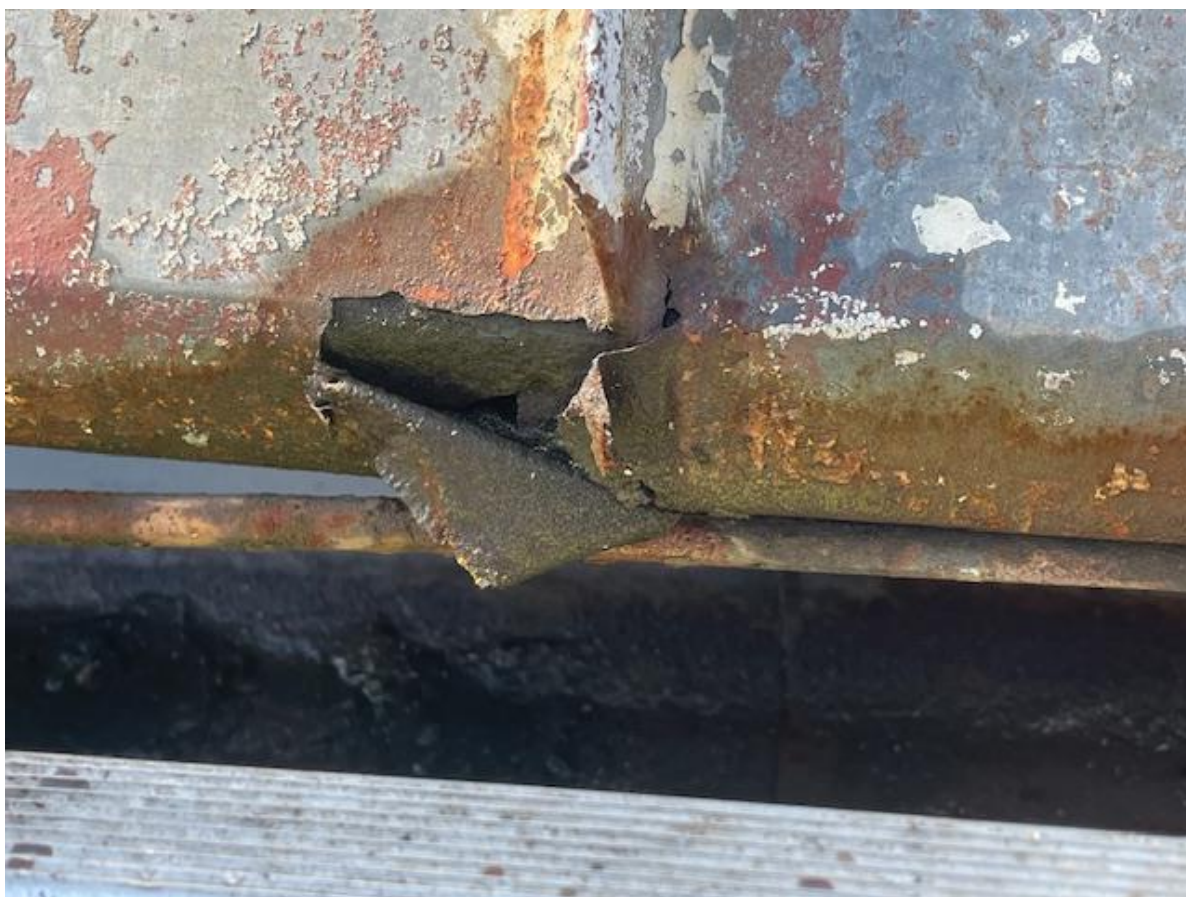
Kondenzácia jedno-plášťovej strešnej skladby degraduje odkvapovú hranu.
