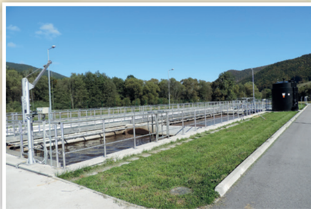
ČOV Liptovská Osada
