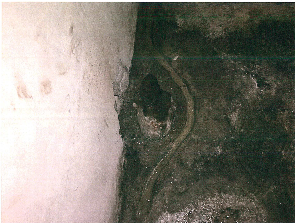
Obr. č. 9 Ventil bez možnosti opravy a manipulácie
