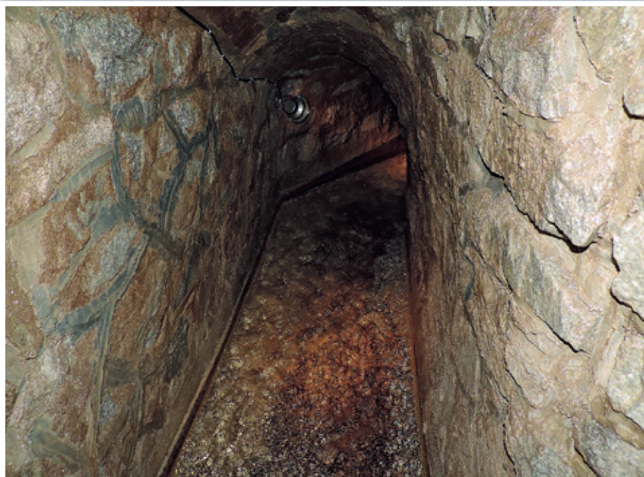
Vodárenský objekt – vodný zdroj Jazierce
