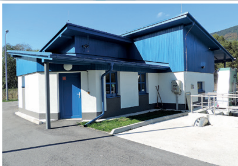
ČOV Liptovská Osada
