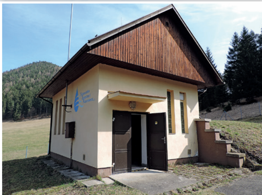
Vodárenský objekt prerušovací vodojem Liptovská Osada 150 m 3
