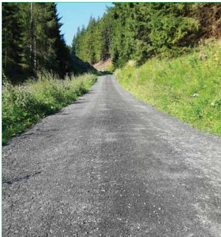
Rekonštrukcia cesty Suché Hrabovo si vyžiadala značné finančné prostriedky
