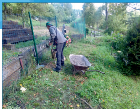
Oprava plotu na cintoríne
