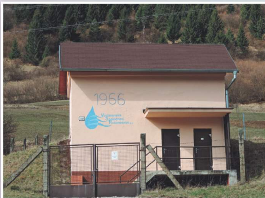
Vodárenský objekt vodojem Biely Potok 150 m 3
