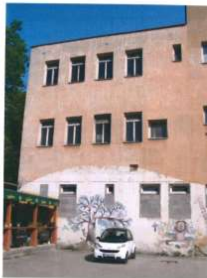
pohľad zadný od parc.č. C KN 128/1
