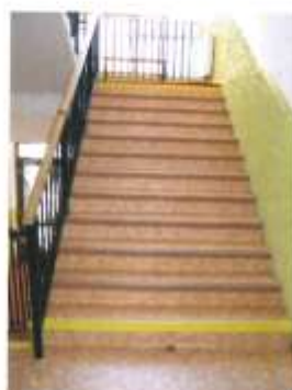
schodisko do II. NP 201
