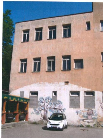
pohľad zadný od parc.č. C KN 128/1
