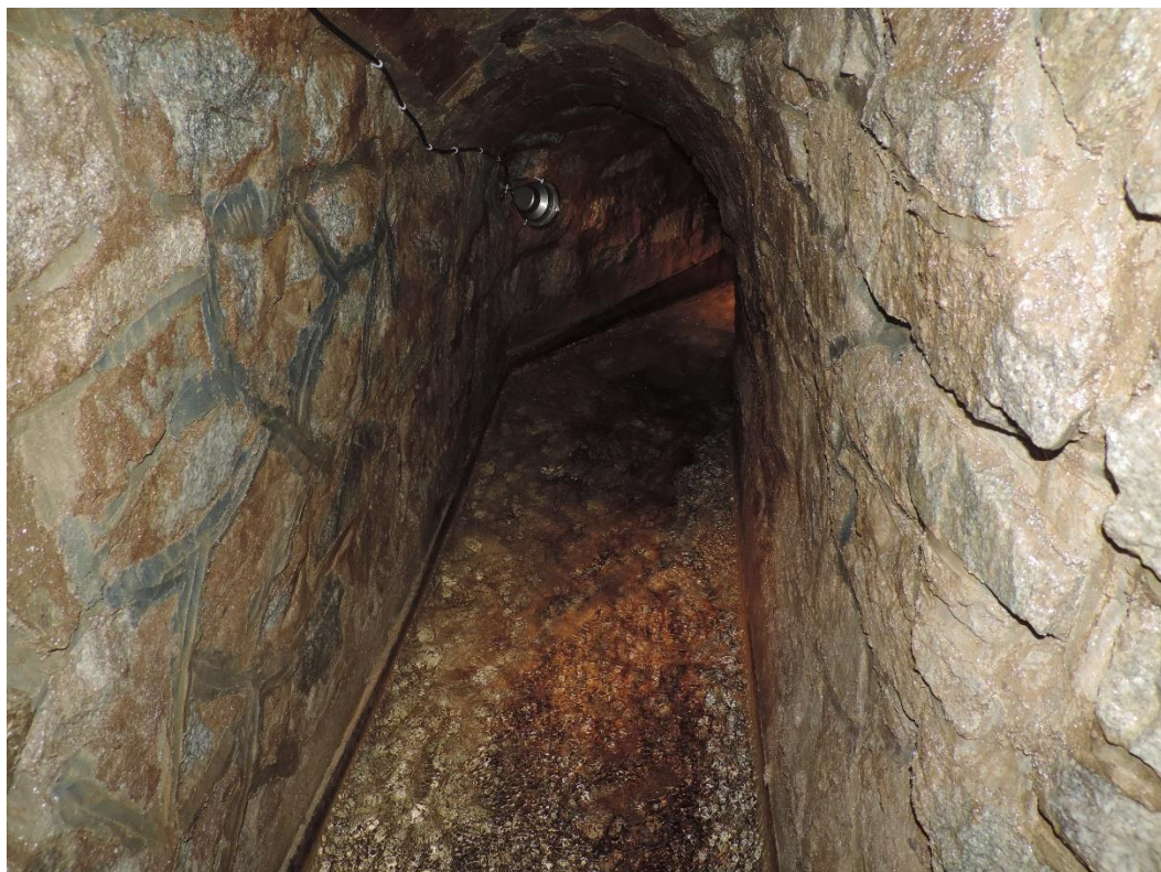
Obr. Vodárenský objekt – vodný zdroj Jazierce
