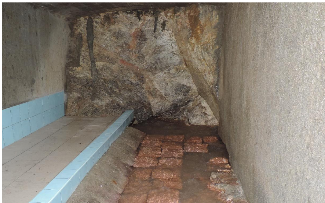
Obr. Vodárenský objekt - Vodný zdroj pod Javorom
