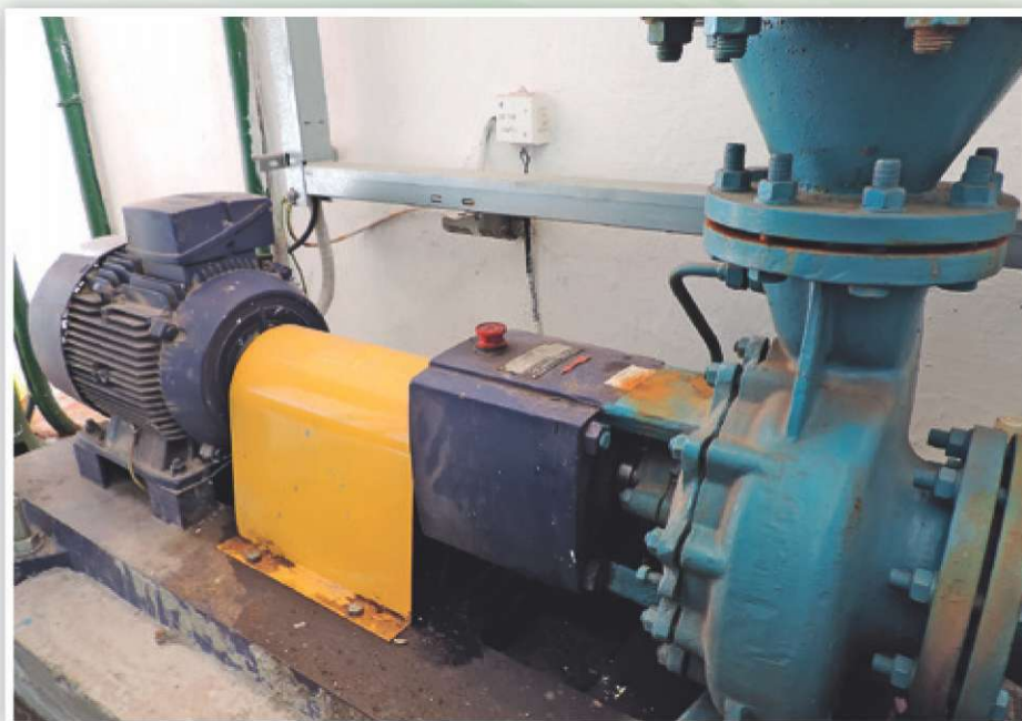
Vodárenský objekt – MVE Biely Potok
