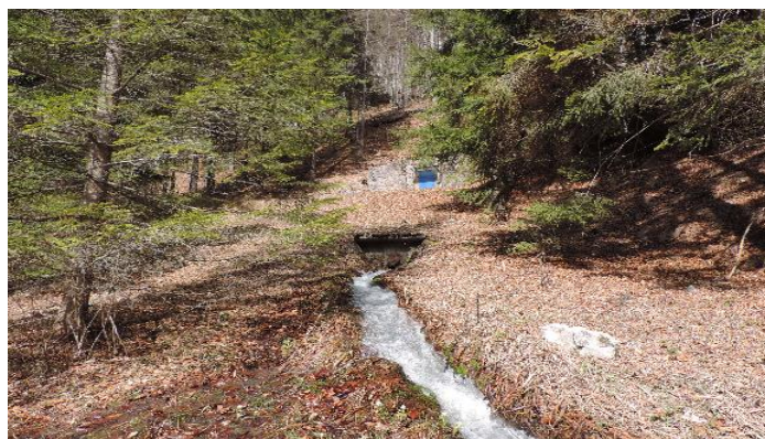
Obr. Vodárenský objekt – prameň Pod Javorom
