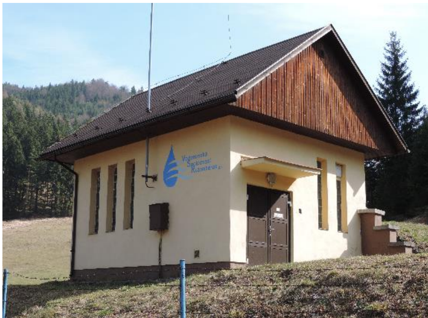
Obr. Vodárenský objekt – MVE Liptovská Osada
