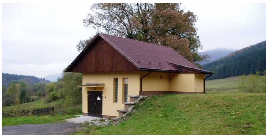
Obr. Vodárenský objekt – prerušovací VDJ L. Osada 150m 3
