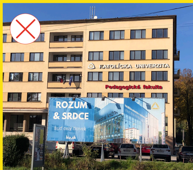
Žilinská cesta - zlý príklad označenia prevádzky univerzity pomocou nevhodného typu a farebnosti názvu fakulty a typu veľkoplošnej reklamy
