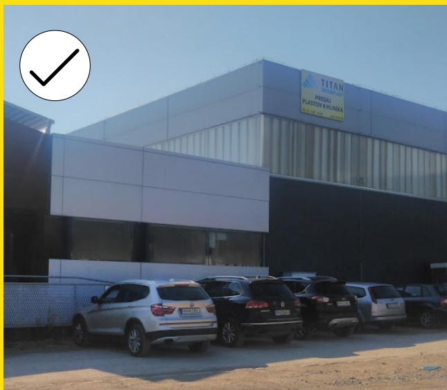
Bystrická cesta - dobrý príklad označenia budovy plôch výroby jednoduchou reklamnou stavbou umiestnenou na fasáde budovy
