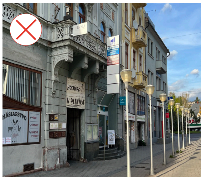
Mostová - zlý príklad vývesných štítov viacerých prevádzok na jednej budove (štít môže mať iba jedna hlavná prevádzka)
