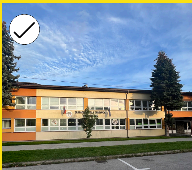
Zarevúca - dobrý príklad označenia prevádzky zákl. školy pomocou samostatných písmen umiestnených na fasáde
