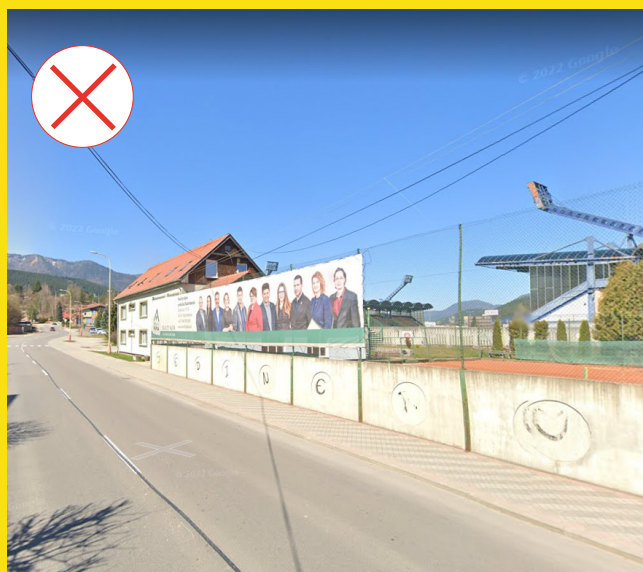
D. Makovického - zlý príklad veľkoplošnej reklamnej stavby umiestnenej na oplotení športovej plochy
