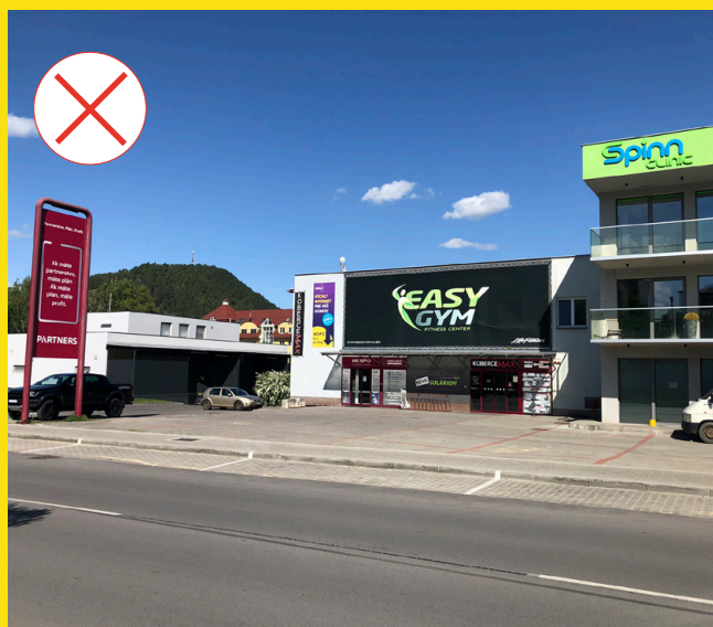
Plavisko - zlý príklad umiestnenia veľkoplošnej reklamnej stavby na fasádu budovy
