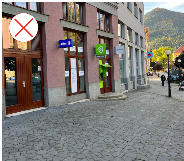
A. Bernoláka - zlý príklad vývesných štítov viacerých prevádzok na jednej budove
