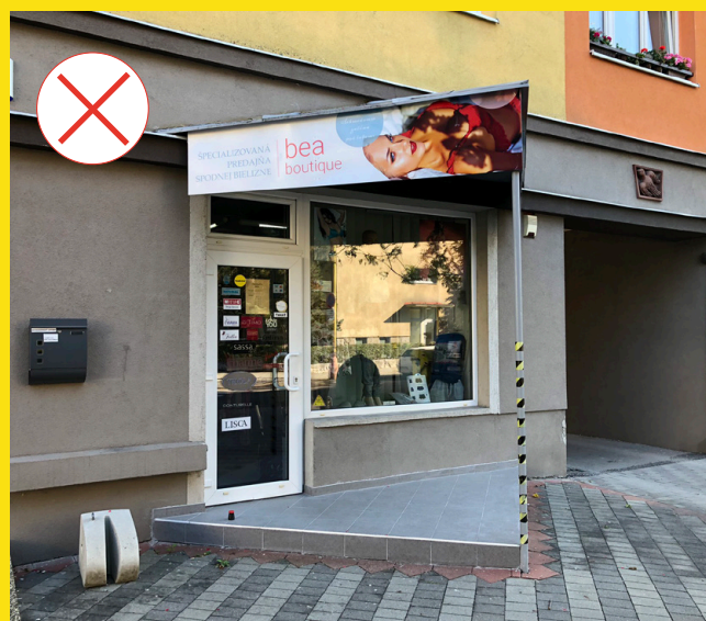
V. Šrobára - zlý príklad označenia prevádzky samostatnou vysunutou konštrukciou
