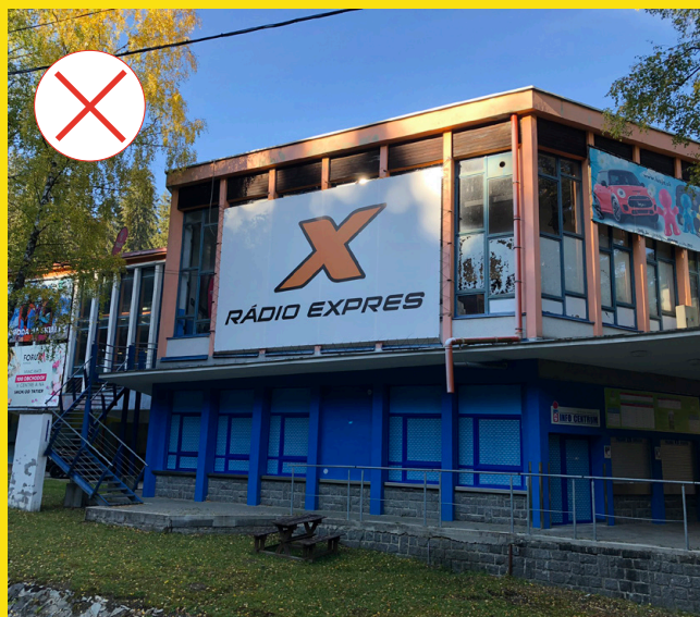
Hrabovská dolina - zlý príklad umiestnenia veľkoplošnej reklamy na fasádu ikonickej budovy
