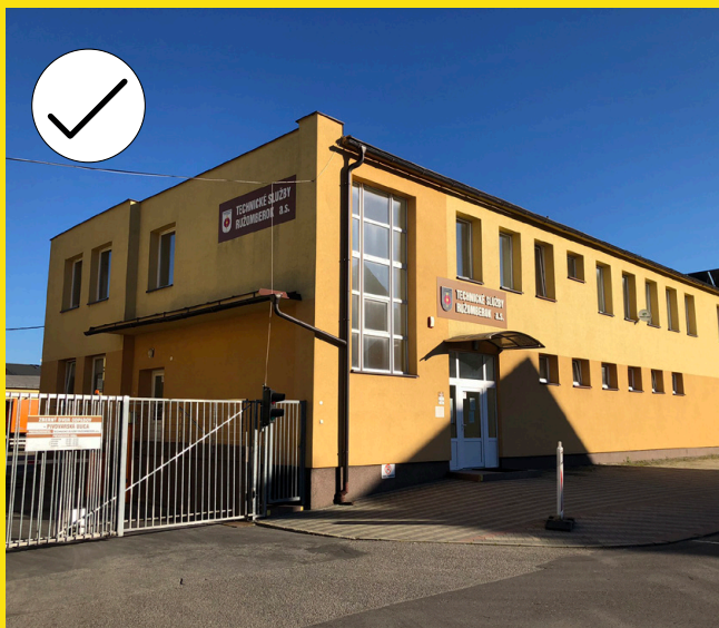
Pivovarská - dobrý príklad označenia prevádzky technických služieb umiestnenej na fasáde budovy
