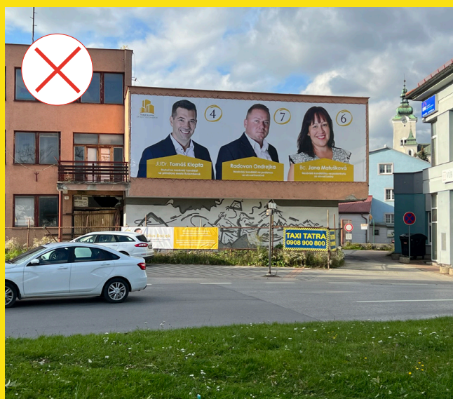
Riadok - zlý príklad umiestnenia veľkoplošnej reklamnej stavby na fasádu budovy
