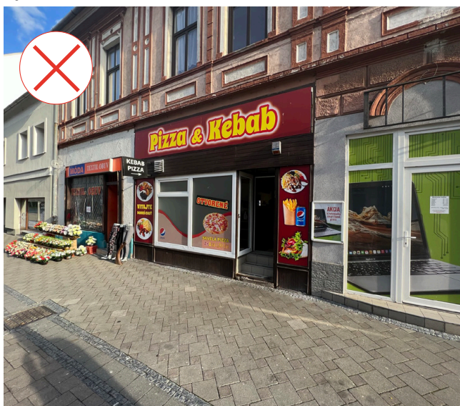
Mostová - zlý príklad prekrytia výkladu väčšiny výkladu nevhodnou reklamou
