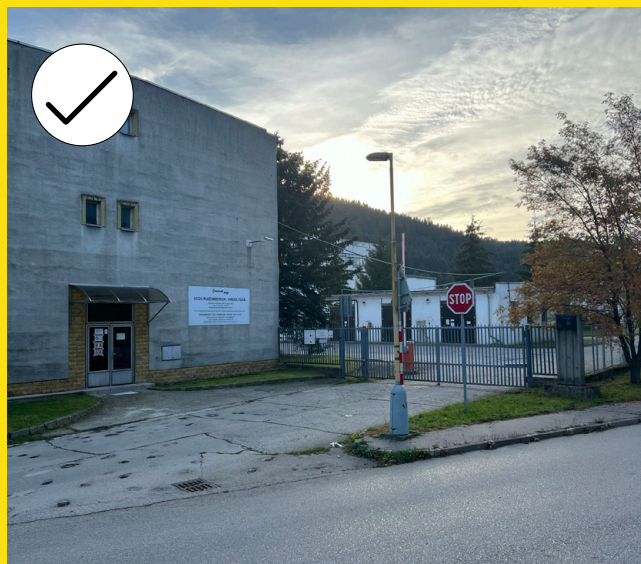
Potočná - dobrý príklad označenia prevádzky ČOV umiestnenej na fasáde budovy
