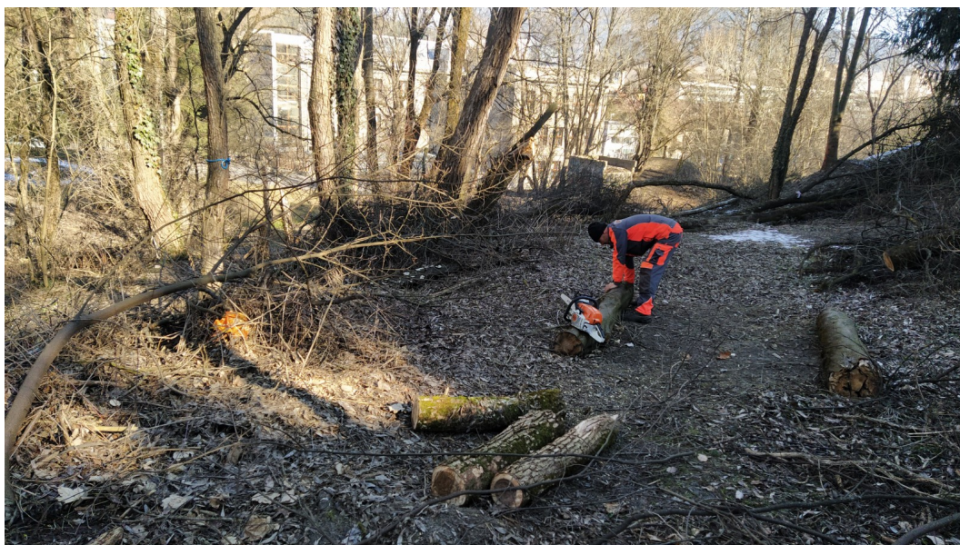
Práce v areály bývalého skokanského mostíka
