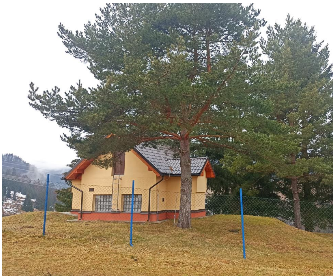
Obr. Vodárenský objekt –Vodojem Liptovská Osada 2x100m3
