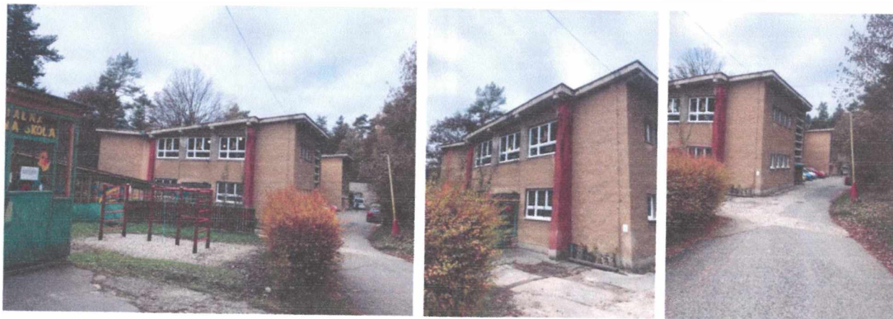
Pavilón Základnej školy s.č. 6407, na parc.č. C KN 16629/2 k.ú. Ružomberok
